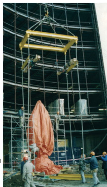
Hefbalk in kadervorm met hefvermogen 40t voor de verplaatsing van een standbeeld. (Keizer Karel gebouw, Brussel 2000)
