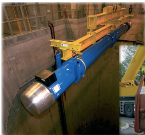
Afdaling van de eerste cryodipool (35.4 t) tot 100 m onder de grond. (CERN, Genève 2005)
