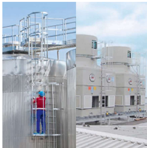
Ladder voor het onderhoud van machines, Hymer 3385 EN ISO 14122-4
